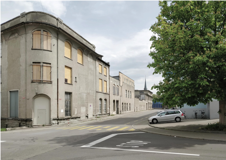
Relief Hallen-Stirnfassaden und Verbindungsbauten
