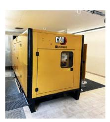
Der Generator hat die Ausmasse eines Containers und wiegt rund 5.3 Tonnen.
