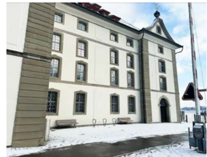
Der Ostteil der Südfassade musste renoviert werden.
