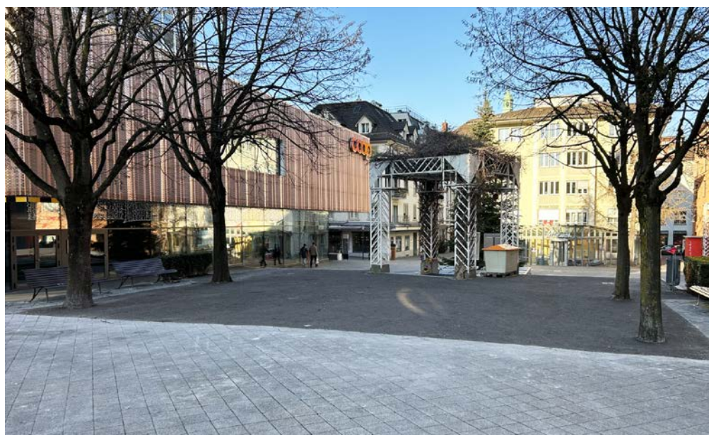
Die Verbundsteine sind auf einer Teilfläche bereits entfernt.
