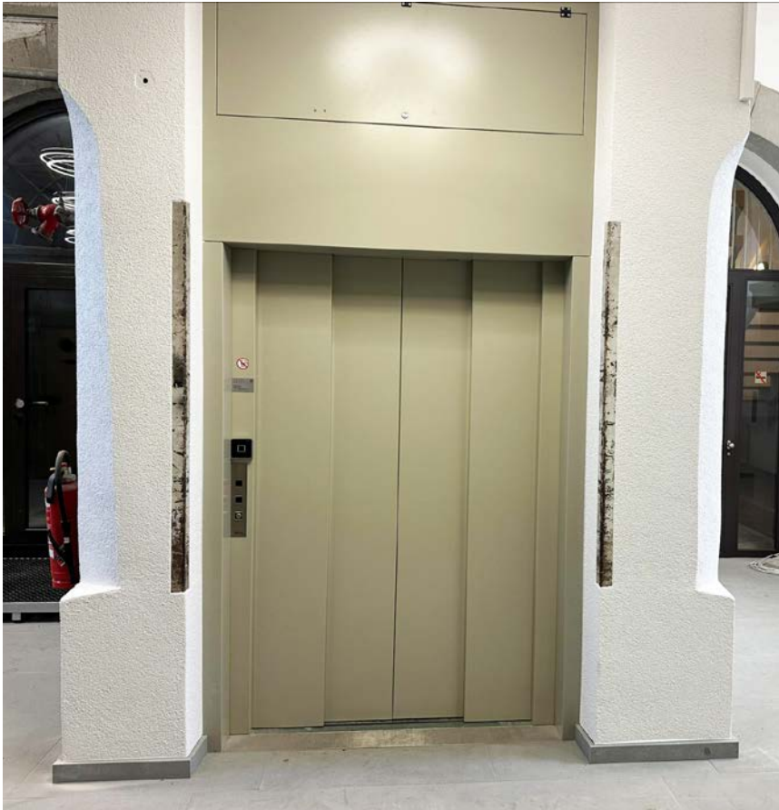
Eine neue Liftanlage ersetzt den alten, störungsanfälligen Aufzug.
