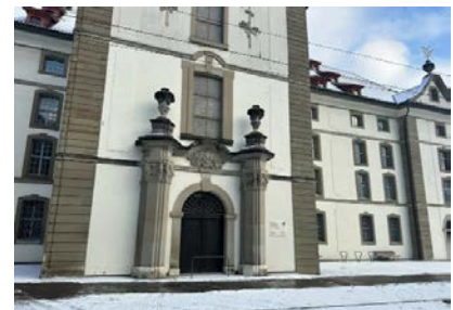
Neu kann man das Kornhaus über den Haupteingang betreten.
