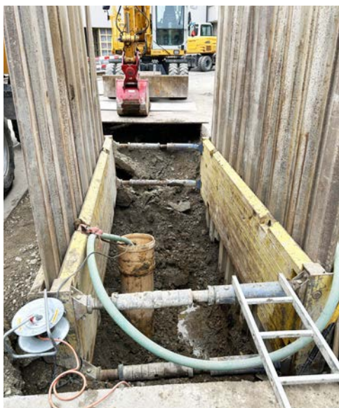
In den kommenden Jahren braucht es Geduld auf Rorschachs Strassen. Es stehen etliche Baustellen an.
