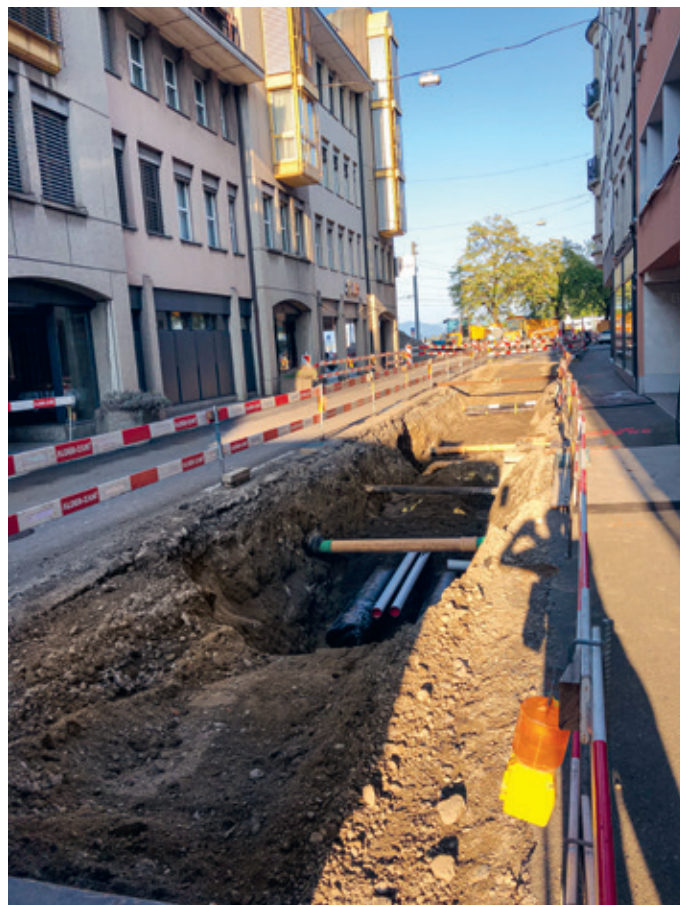
Zusammen mit der Erneuerung der Hauptstrasse werden bereits erste Vorleistungen für ein Anergienetz erbracht.
