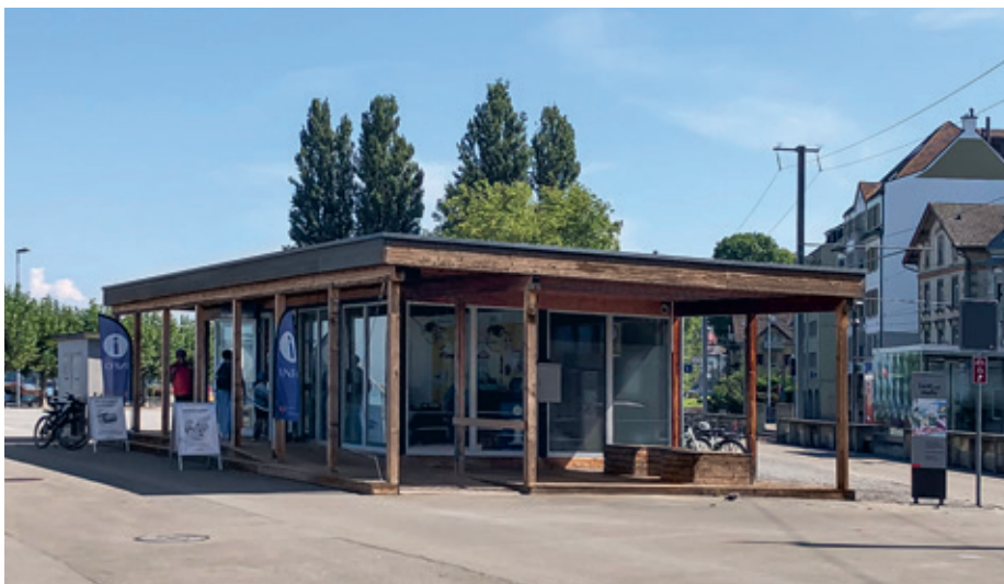
Das provisorische Hafengebäude hat seine Lebensdauer erreicht und muss ersetzt werden.
