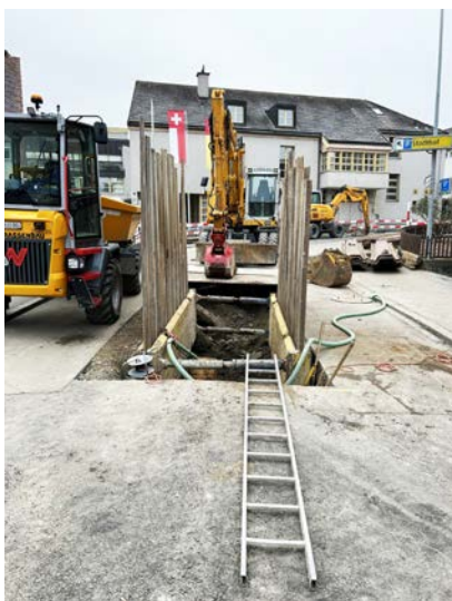
Anergie in der Kirchstrasse: Neue Leitungen in Strassen zu legen ist wegen der bestehenden Werke sehr aufwändig und zeitintensiv.
