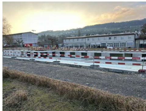
Ein wichtiges Jahresziel für 2025 ist die Fertigstellung der Wasseraufbereitung und der Schwimmbecken im Strandbad Rorschach.
