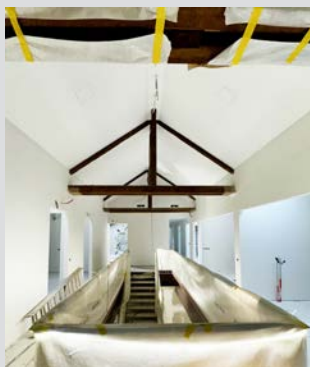
Noch laufen die Bauarbeiten in den Räumlichkeiten des Gesundheitszentrums Rorschach.
