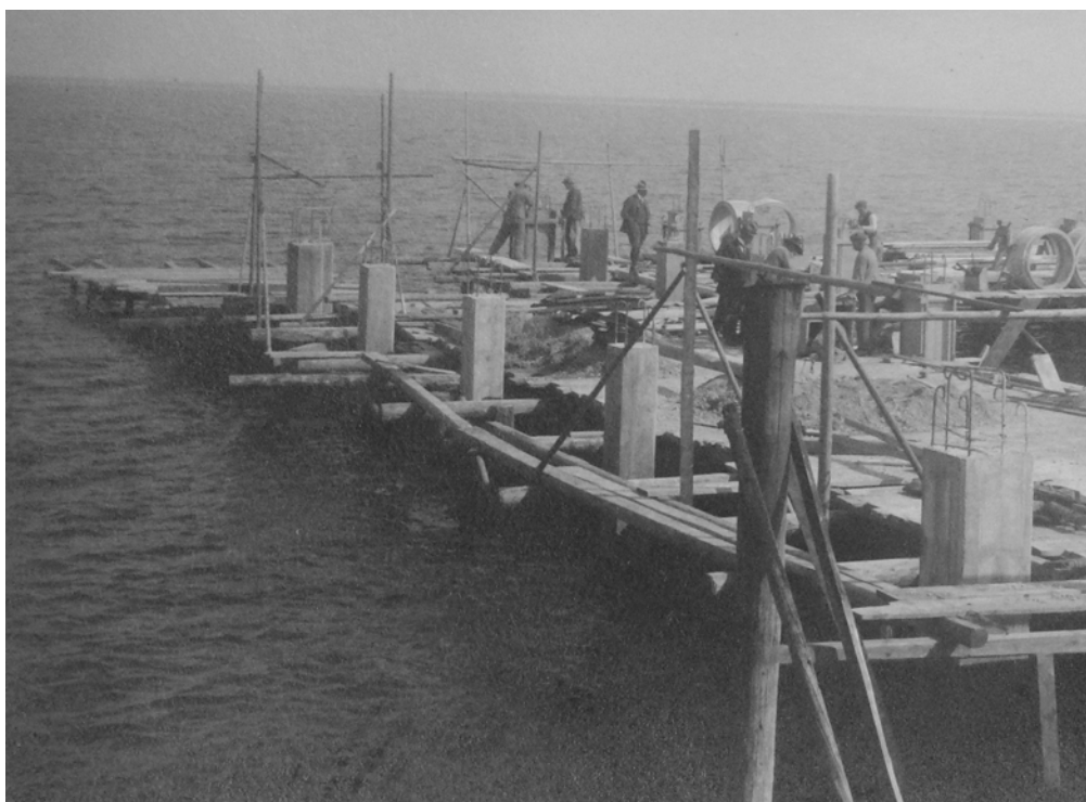
Bau des Betonfundaments der alten Badhütte: Leider kann die Plattform nicht weiter verwendet werden.
