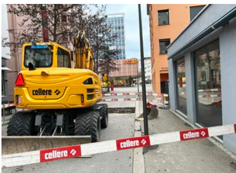
Die Anergieleitung zum Coop-Gebäude wird im Spülbohrverfahren, d.h. unterirdisch, verlegt. Es braucht also keinen durchgehenden Graben.
