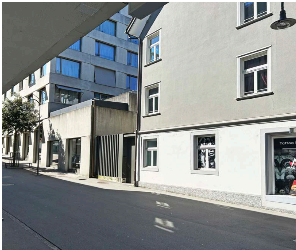
An der Kronenstrasse soll ein weiterer Unterflurbehälter gesetzt werden.
