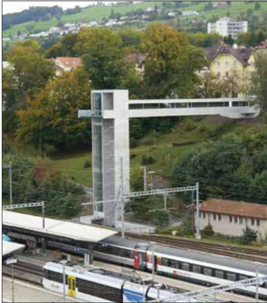
Überwindung der Bahnlinie
